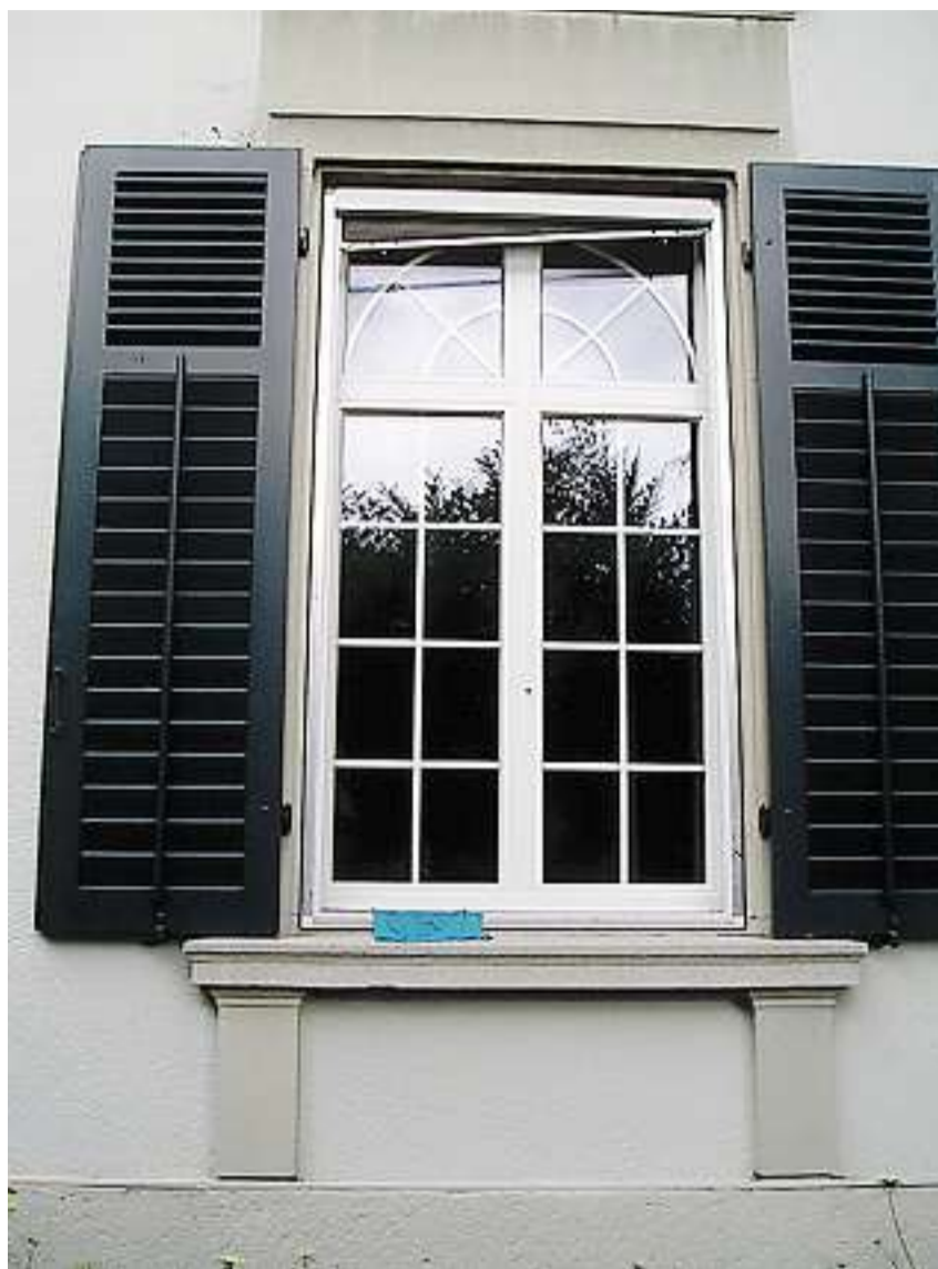
Nicht mehr gebraucht, ist ein Fenster dank Bauteilvermittlung an einem neuen Ort von grossem Nutzen. Bild: zvg
